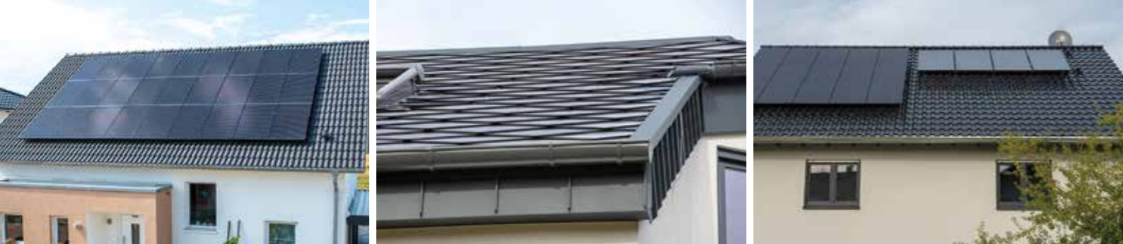
Welche Photovoltaik-Anlage am besten passt, ergibt sich u. a. aus Neigung und Ausrichtung der verfügbaren Dachflächen. Wir beraten Sie gern.
