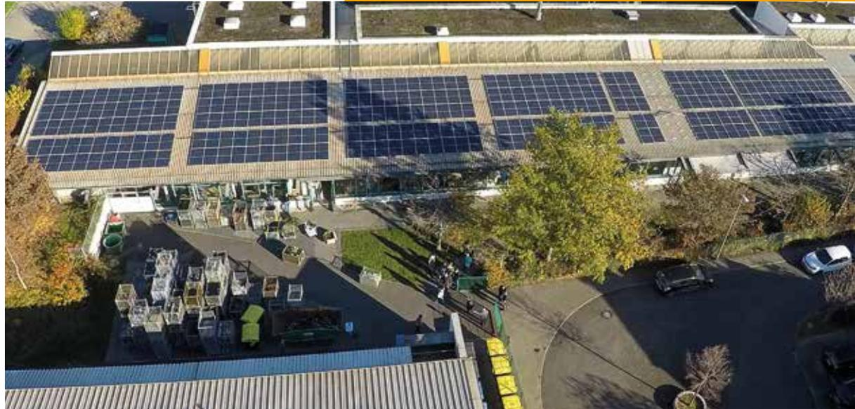
Mit 350 Photovoltaikmodulen produziert das Facettenwerk in Oestrich-Winkel rund 100.000 kWh Sonnenstrom.
