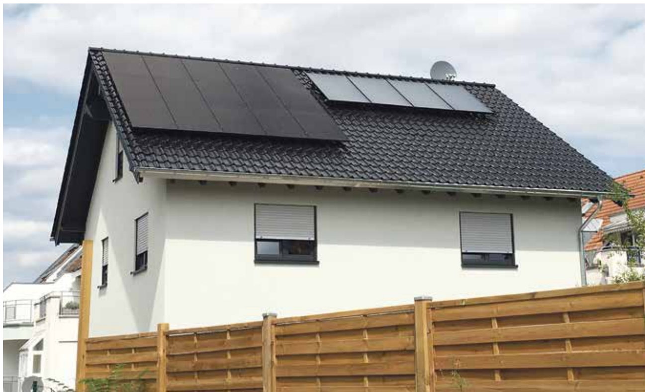
Mit solch einer modernen PV-Anlage lässt sich Strom selbst erzeugen.
