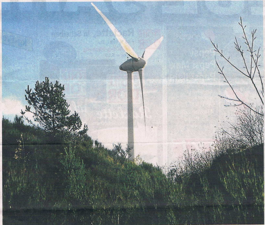
Der Windpark auf dem Kandrich gilt als einer der besten Windstandorte in ganz Deutschland. Foto: Gedeä
